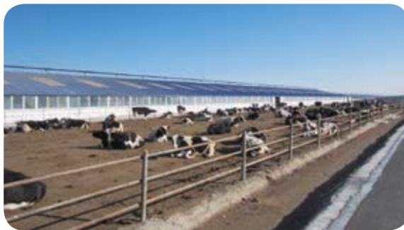
圖：各牧場增加雨污分流設施，每個牛舍運動場周邊建設混凝土結構的排水溝，防止雨水經污染後下滲污染地下水。
